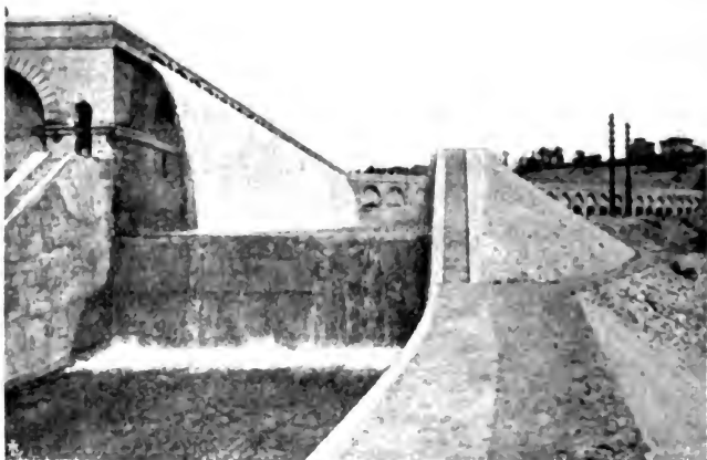
IMPIANTO IDRO-ELETTRICO DI VIZZOLA-TICINO. — Bacino di presa.
